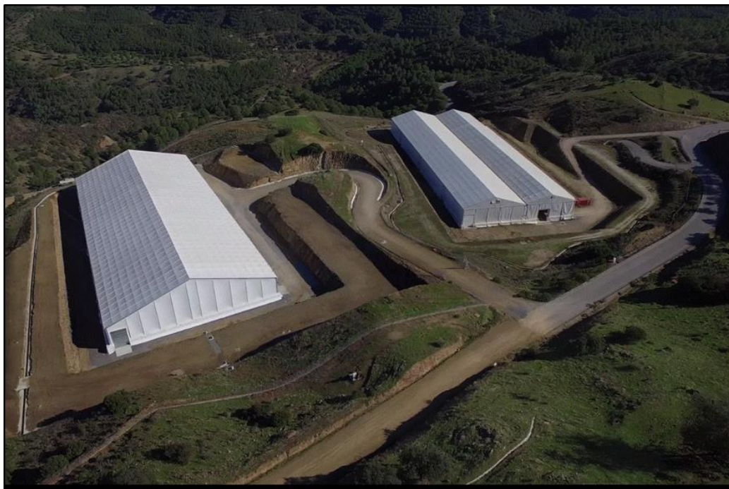
Figura 12. Instalación complementaria para el almacenamiento de RBBA
