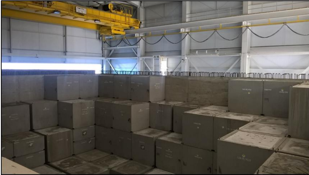
Figura 11. Celda de almacenamiento de RBMA
