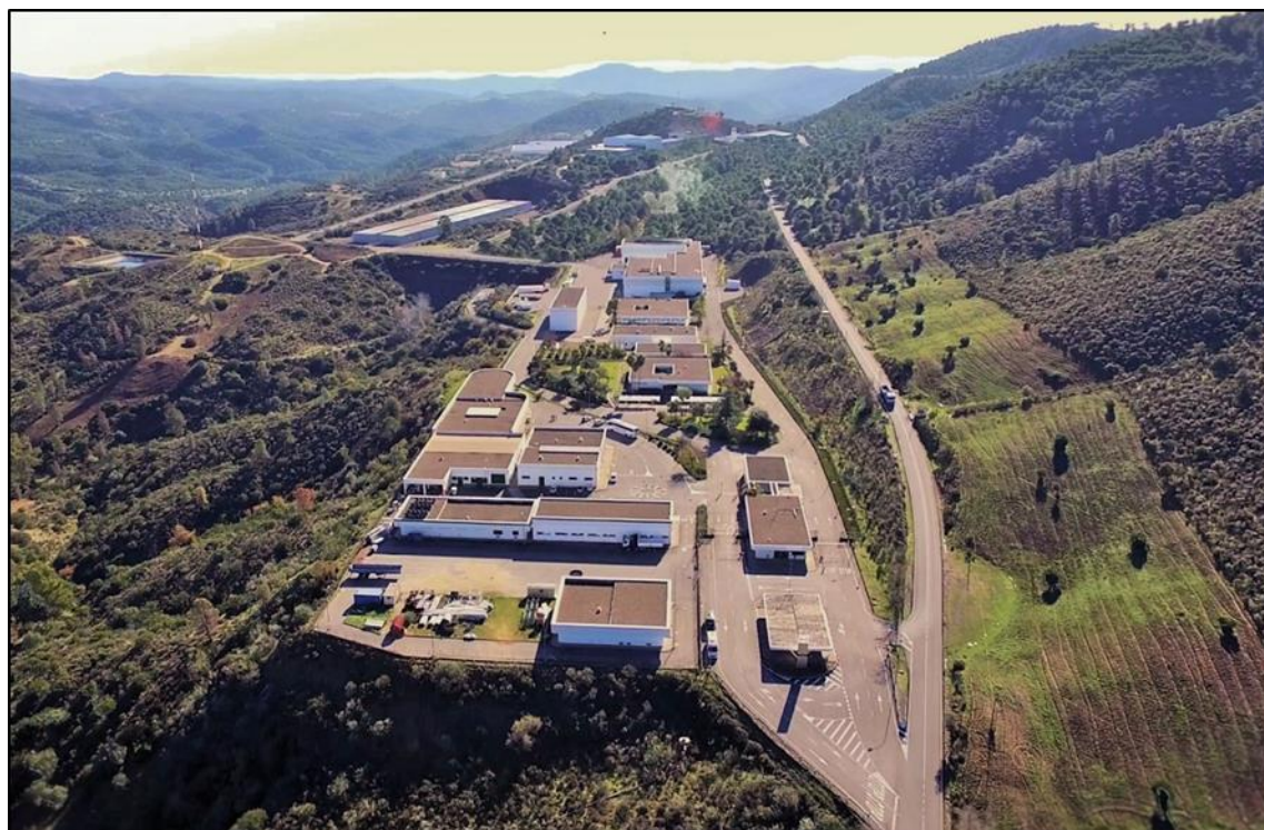
Figura 9. Vista aérea de la instalación de CA El Cabril
